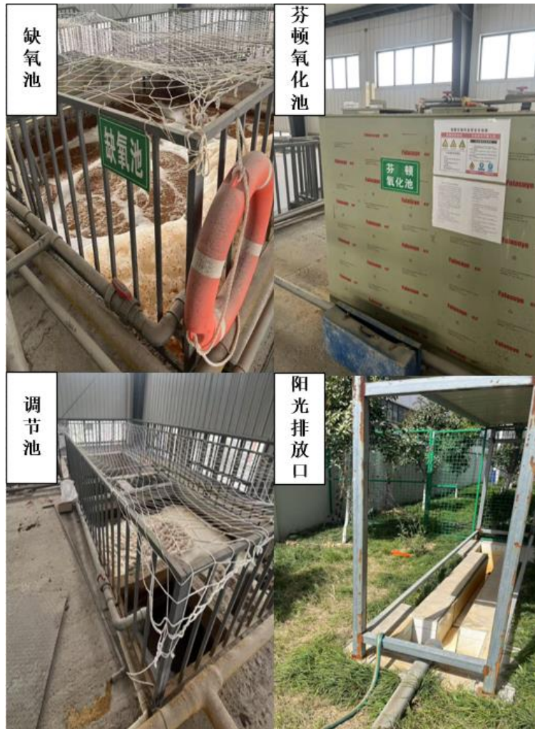
图 3-2 废水处理设施现状
