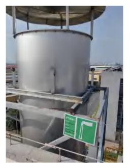
图 3-7 印刷、复合、固化废气处理设施排气筒
