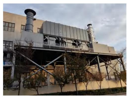
图 3-3 印刷、复合、固化废气处理设施现场照片
