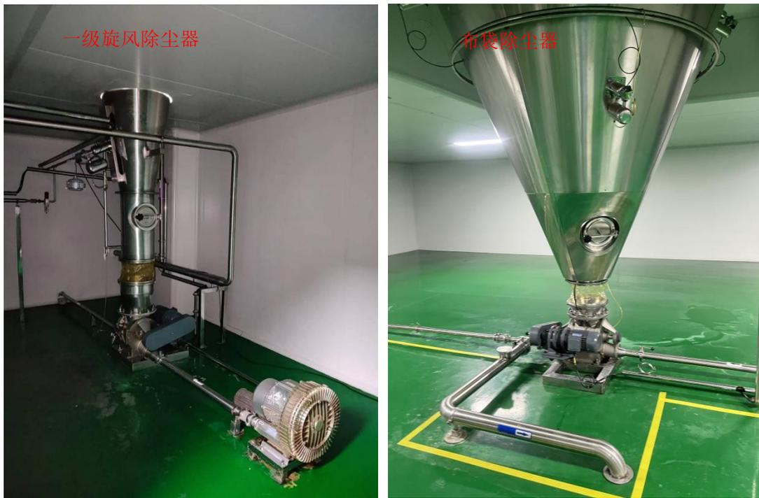
图 3-4 有组织废气处理设施现场照片
