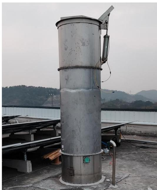
图 3-6 喷雾干燥废气排气筒
