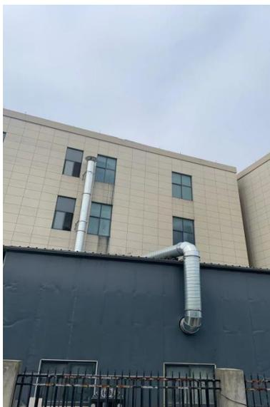
图 3-4 切割废气排气筒
